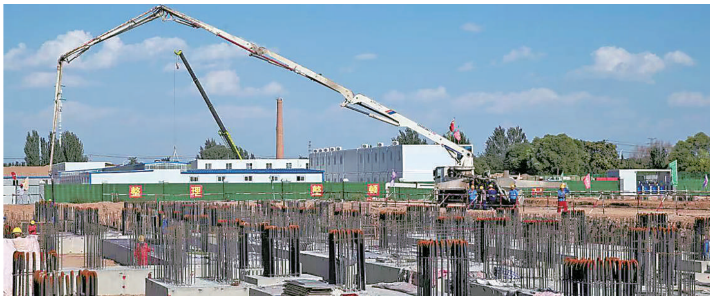
项目建设现场。
