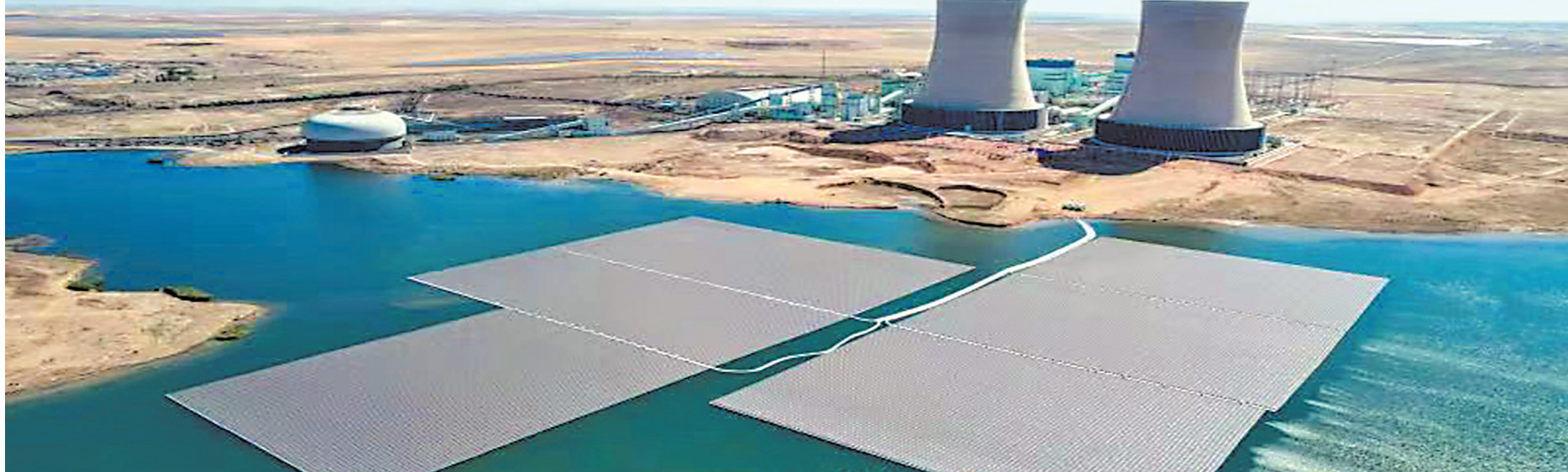
这是我区首个水上漂浮光伏电站——国家能源集团宁夏电力公司宁东电厂3x5.98兆瓦漂浮分布式光伏电站。该漂浮电站的建设,为在更多矿并疏干水域建设光伏电站、盘活闲置区域起到实验示范作用。
