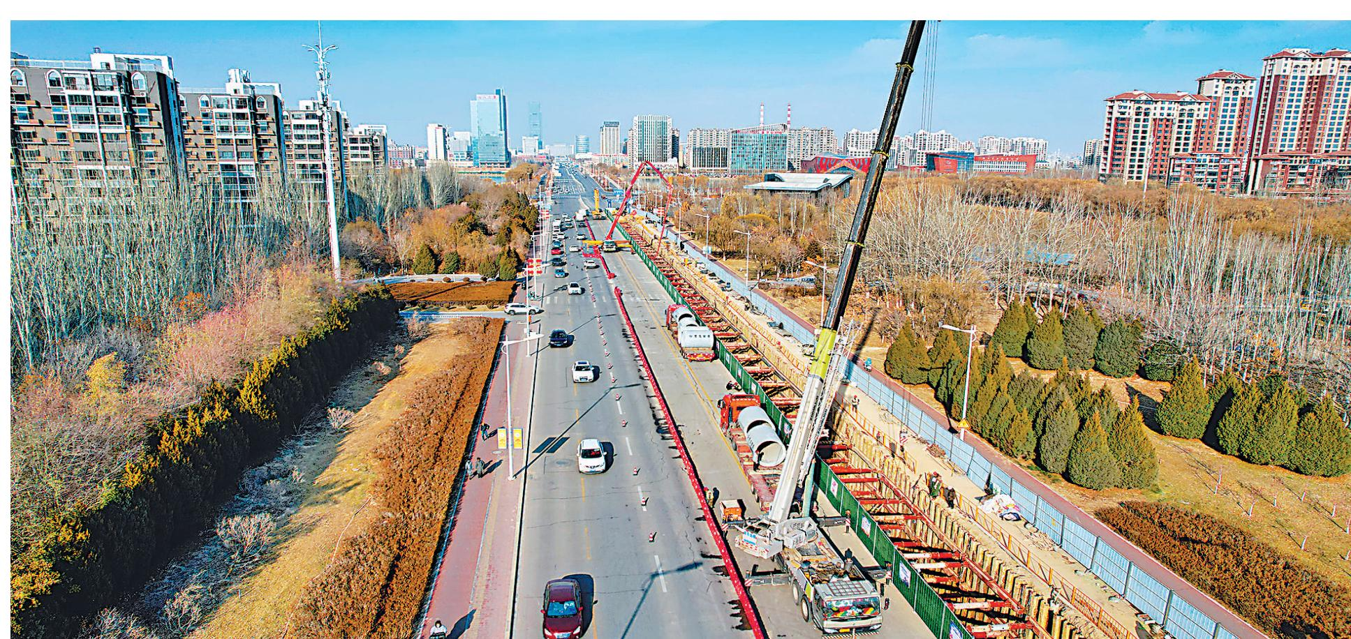
12月12日,银川市金凤区宁安南大街,工人们在大型工程机械的配合下进行沟槽开挖、雨水管道铺设和井室砼浇筑等施工作业。今年,银川市共实施居住社区、道路广场、绿地、水系、公园等融入海绵城市建设理念的项目40个,计划总投资26.8亿元。本报记者 马楠 摄
