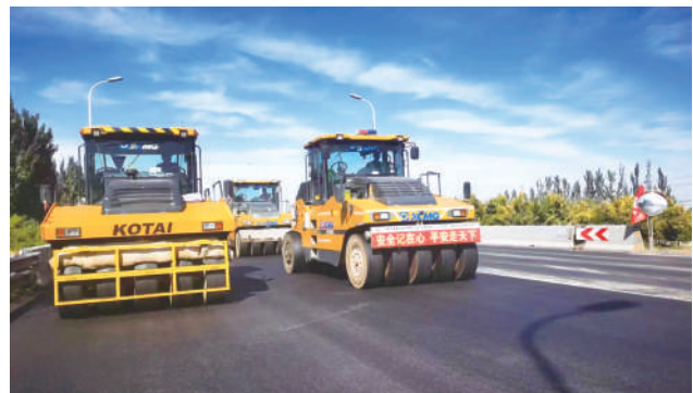
积极实施国省道干线公路路面养护工程。
