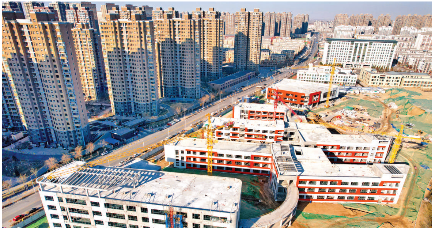
12月26日,银川市阅海第五小学工程项目已具雏形。据了解,银川市第四十二中学与阅海第五小学工程项目位于银川市金凤区万安巷以东、阅欣路以南、唐徕渠以西。银川市第四十二中学设计36个教学班,可容纳1800名学生,银川市阅海第五小学设计44个教学班,可容纳1980名学生,两所学校预计2023年6月完工,8月可招收第一批新生入学。
