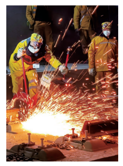
图为香山隧道内施工场景。
