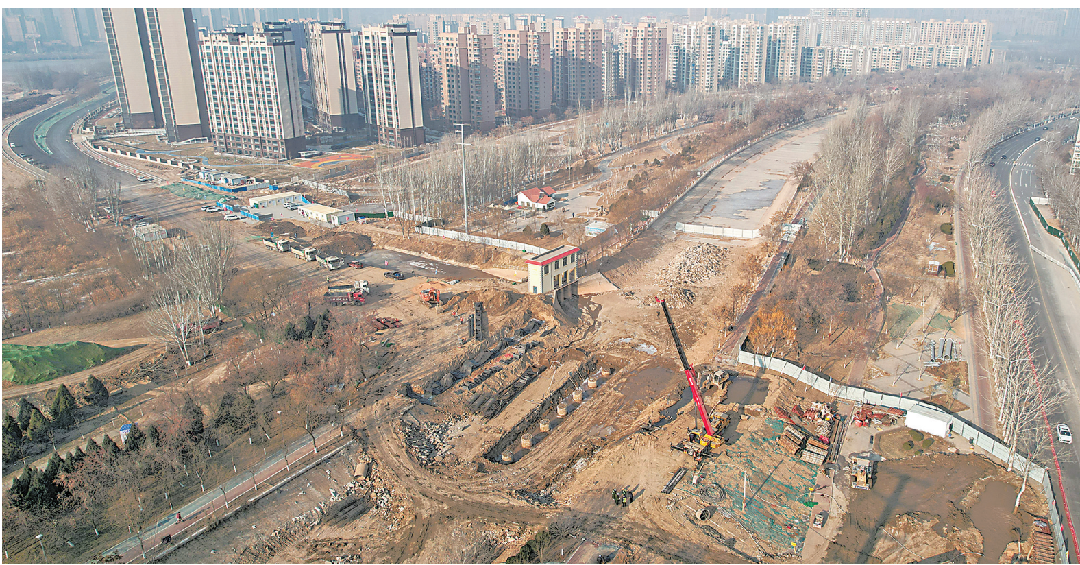
党的二十大报告指出,坚持人民城市人民建、人民城市为人民,提高城市规划、建设、治理水平,加快转变超大特大城市发展方式,实施城市更新行动,加强城市基础设施建设,打造宜居、韧性、智慧城市。1月3日,建设中的银川市金凤五路跨唐徕渠桥梁主跨工程。金凤五路工程是银川市交通疏堵“6+N”工程重点项目之一,预计今年5月完工达到通车条件,届时银川城南道路交通将得到再度优化,并缓解宝湖路和六盘山路交通压力。本报记者 党硕 摄
