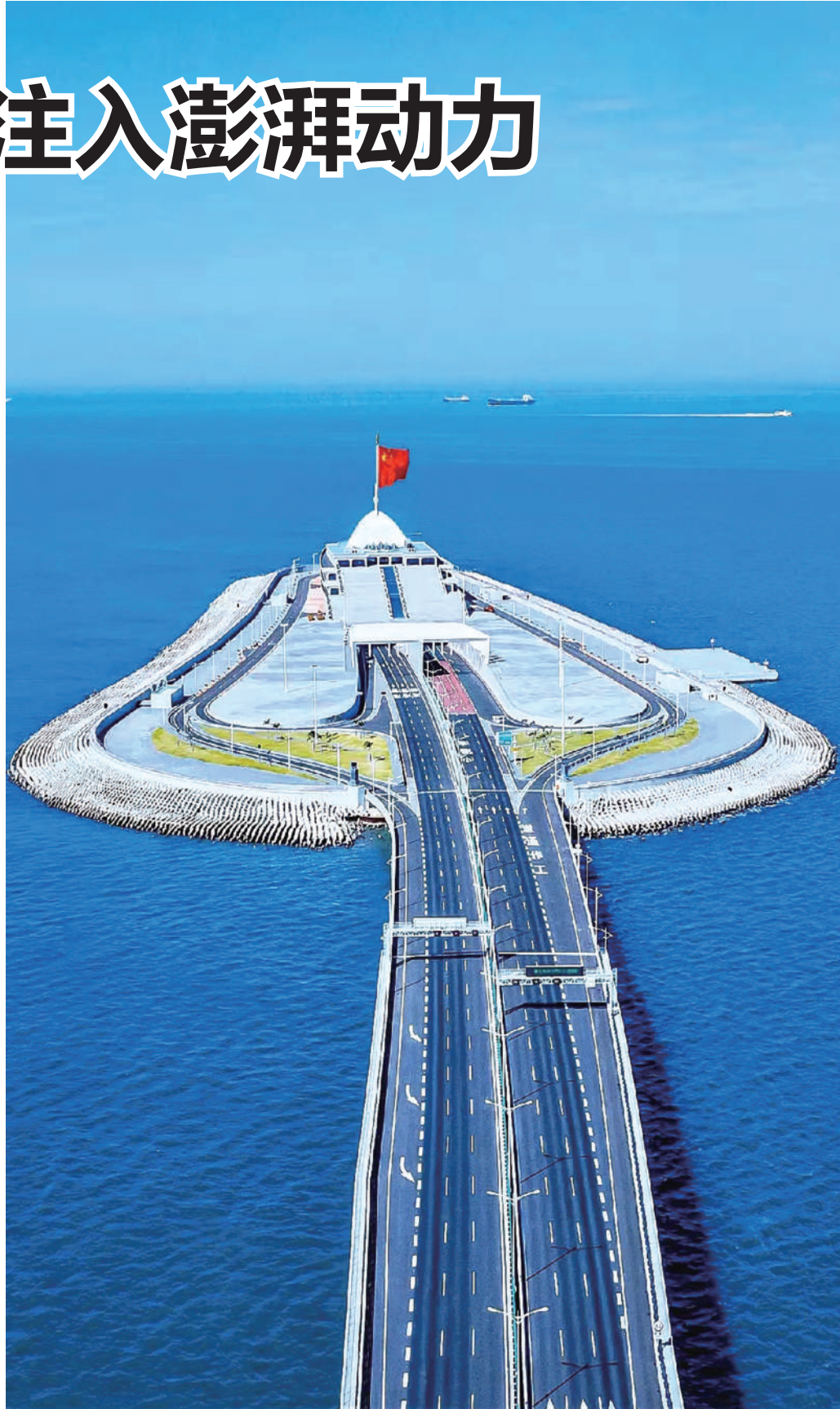
参与实施的港珠澳大桥地下连续墙维护工程。
