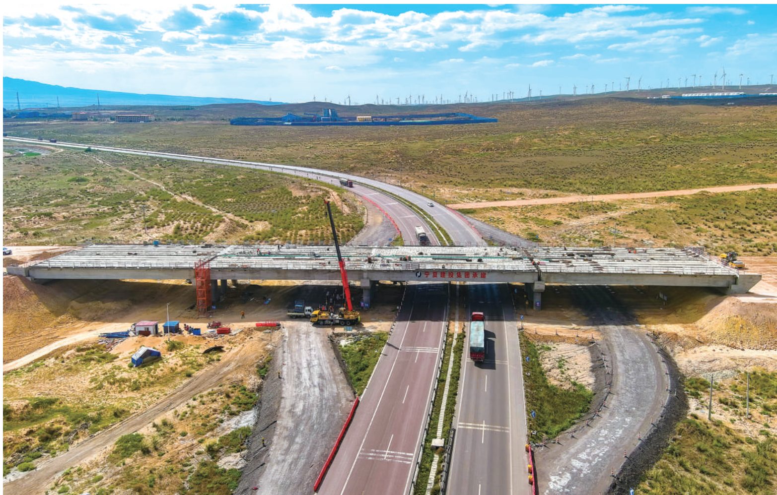
参与实施的银昆高速公路跨定武高速公路桥梁工程。
