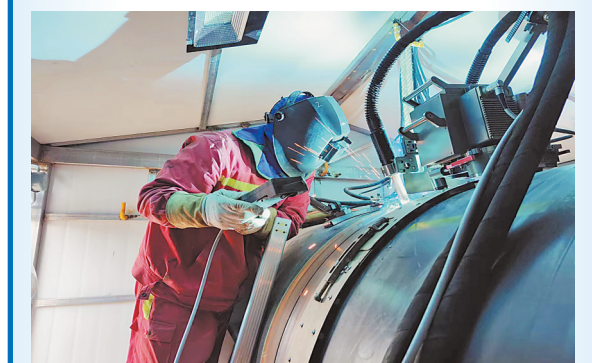
西气东输西三线天然气项目施工现场。
