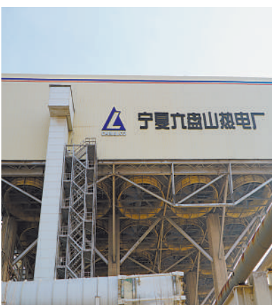
六盘山热电厂厂址全面开工。
