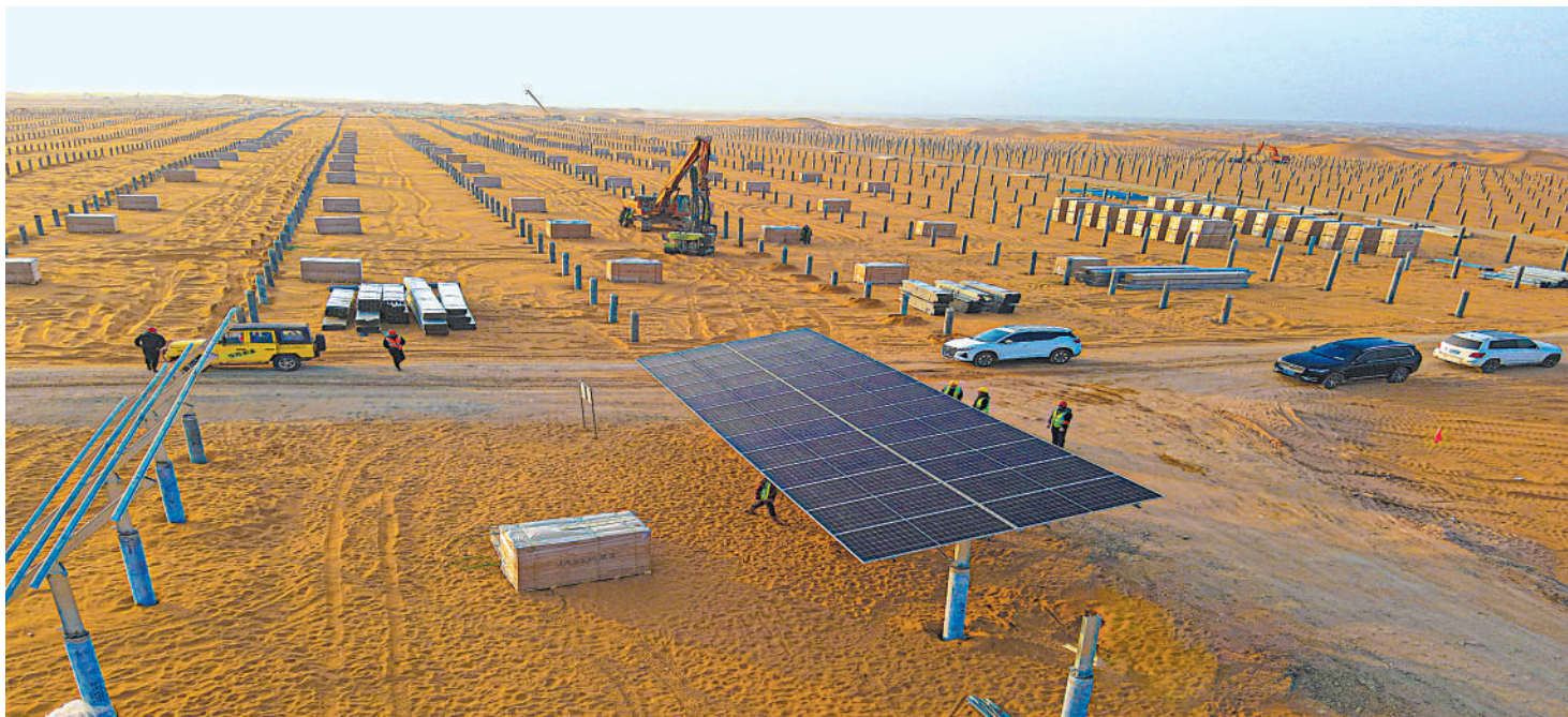
腾格里沙漠中卫新能源基地正在建设中。
