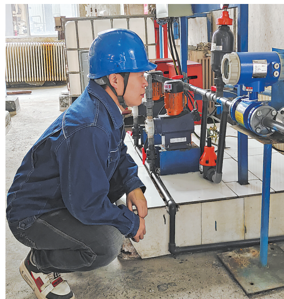
技术人员查看现场药剂添加情况。
