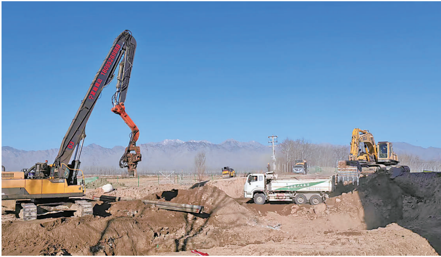
金山泵站、林场泵站工程施工现场。
