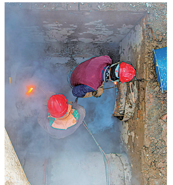
维修工抢修主管网爆管故障。
