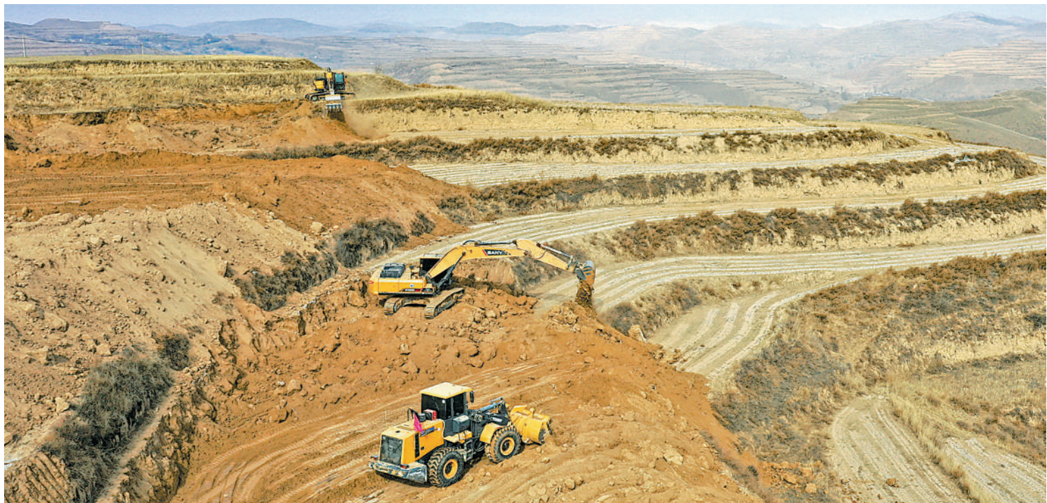
2月7日,工人操作挖掘机、推土机在西吉县硝河乡苏沟村平整土地(无人机照片)。
