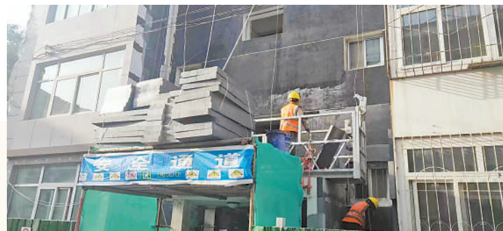
老旧小区外墙保温改造,得到了居民的称赞。
