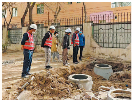
老旧小区易出现下水管道老化现象,管道改造是老旧小区改造的一项重要内容。
