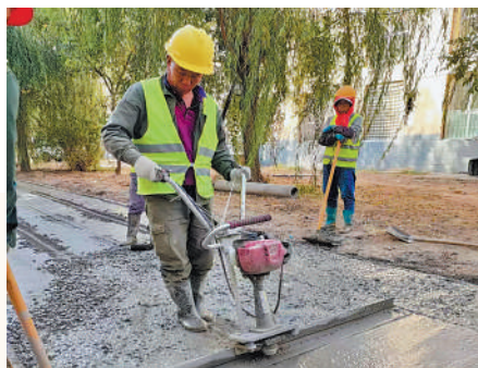
对老旧小区的道路进行改造。(均资料图片)
