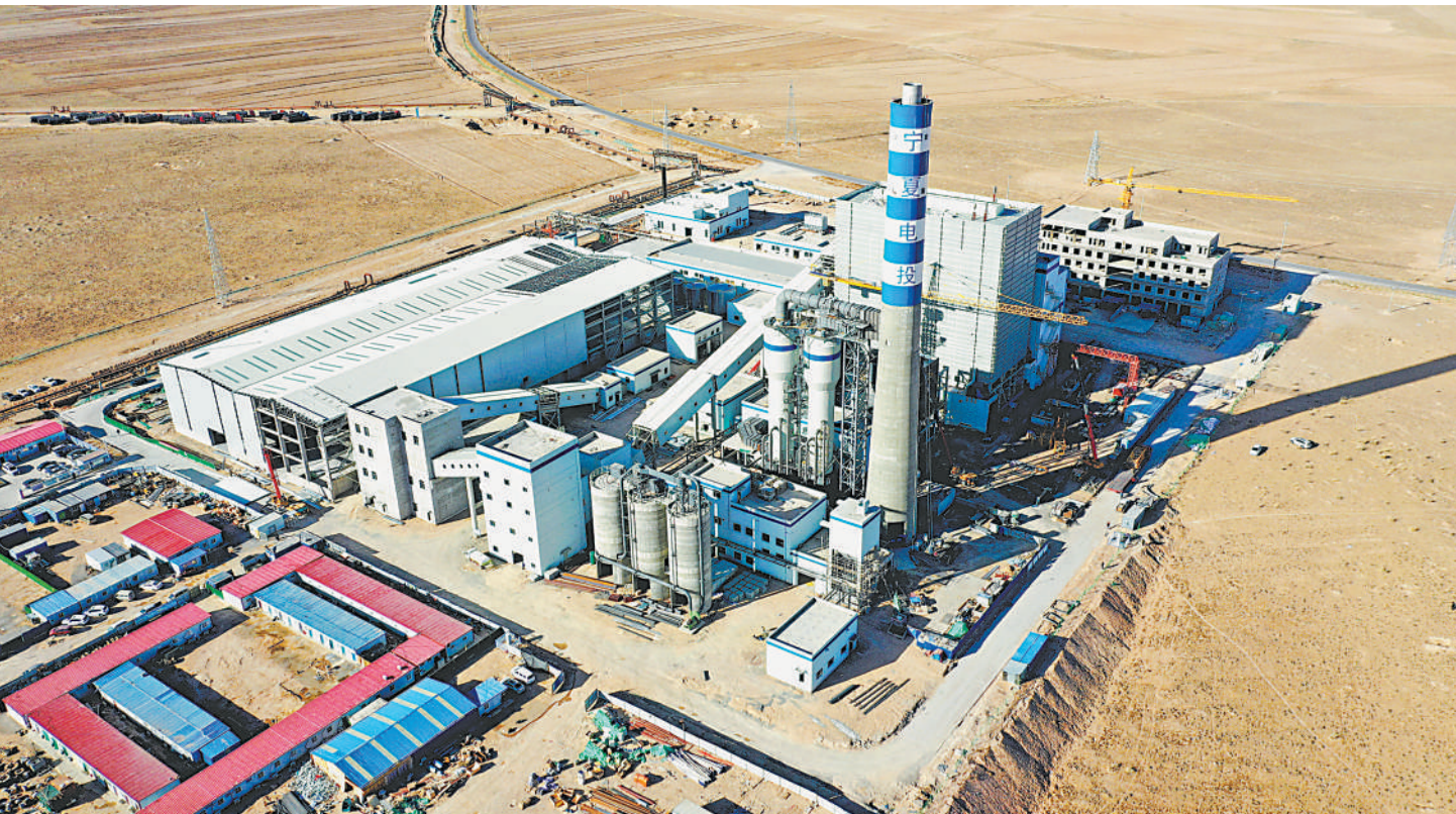
2月19日,宁电投太阳山能源热电联产项目正在加紧建设。该项目以吴忠太阳山开发区为中心点,辐射全国,包括热电联产、160万千瓦光伏发电、装备制造、合成绿氨工厂、电池储能、智能微电网等项目。
