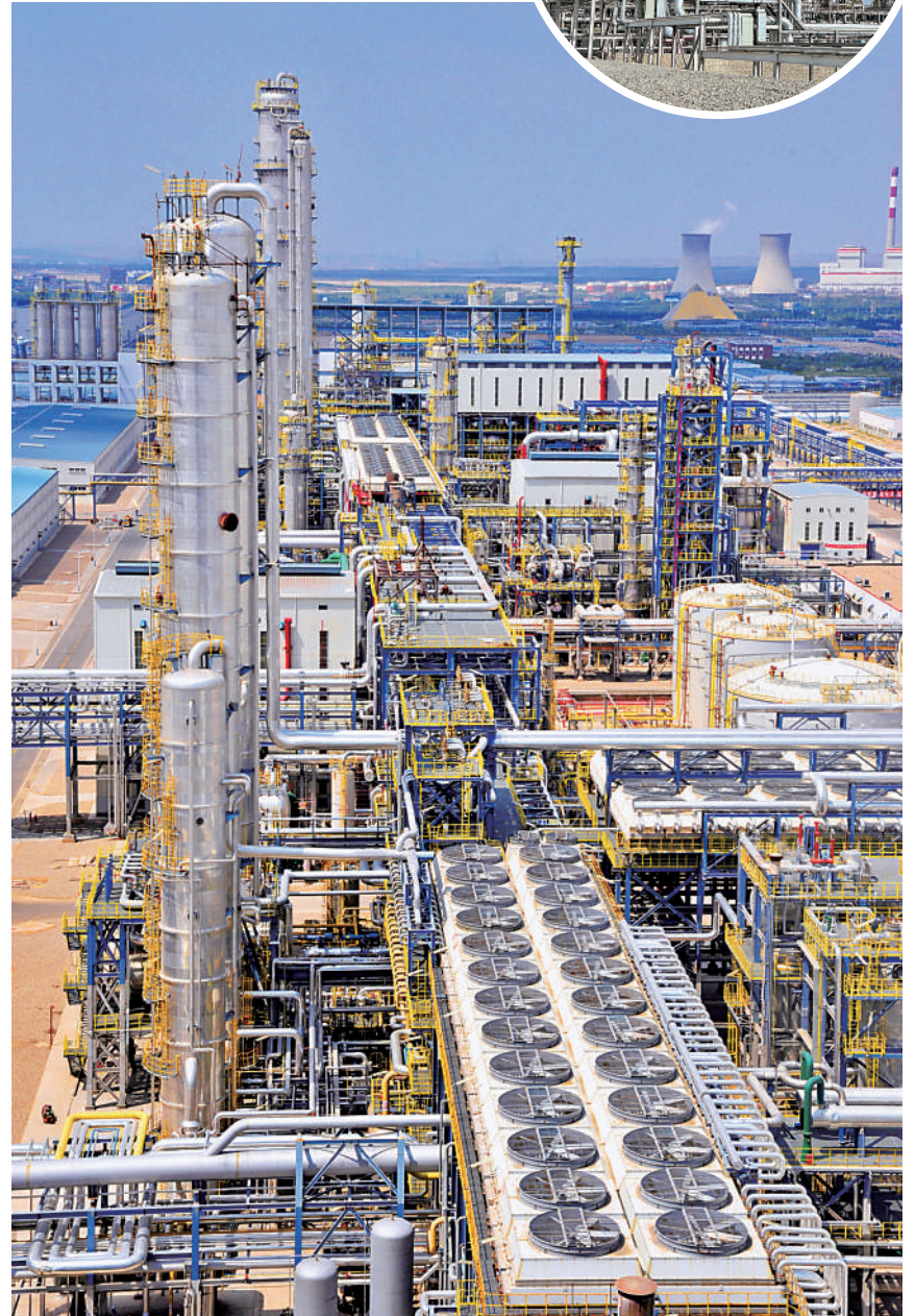
国家能源集团宁夏煤业有限责任公司煤制烯烃项目。(自治区工业和信息化厅供图)
