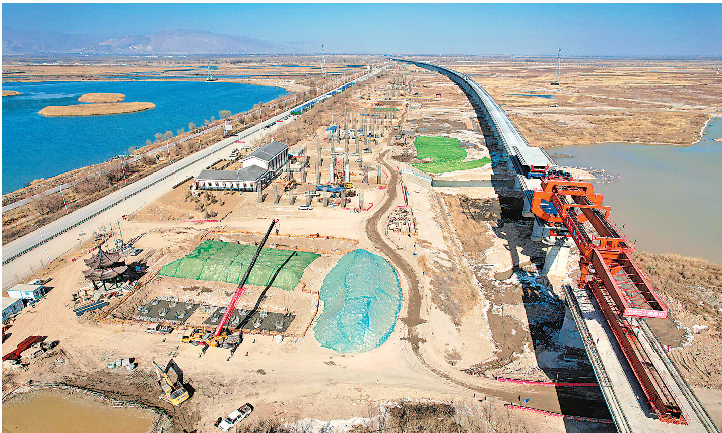
3月6日，包银铁路石嘴山特大桥正在加紧建设。该桥全长39公里，共采用预制箱梁602榀，预计7月中旬全部架设完成。
