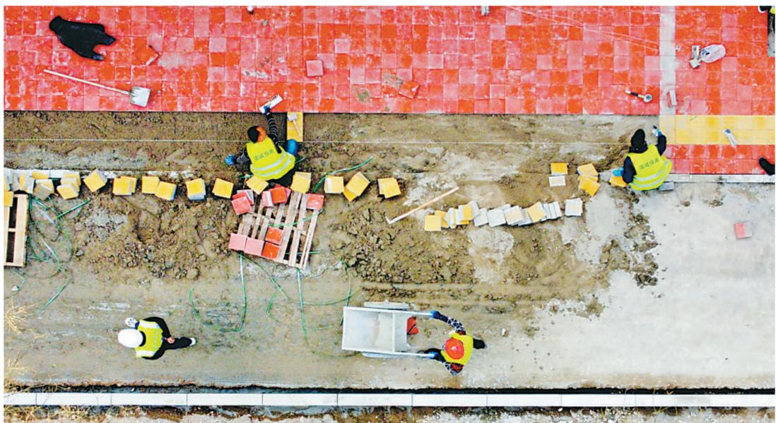
3月19日,银川市兴庆区迎春巷(北京路—上海路)慢行绿道工程施工现场,工人们为硬化路面铺设地砖。该慢行绿道工程北起上海路,南至北京路,全长1003米。工程建设融入海绵城市、园林城市理念,将对道路两侧人行道进行改造,新建绿化隔离带、彩色沥青非机动车道、透水砖人行道等。工程整体计划5月底完成。改造完成后,迎春巷将增加1条车道,可按双向三车道通行,并实现机非分离。 本报记者 马楠 王洋 摄
