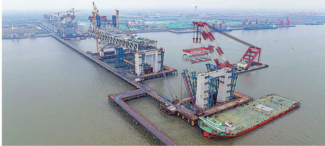
3月20日,中交二航局建设者在常泰长江大桥主航道桥泰州侧施工现场进行首节段钢桁梁架设(无人机照片)。当日,常泰长江大桥主航道桥泰州侧首节段钢桁梁成功架设,标志着常泰长江大桥主航道桥钢桁梁架设工作全面展开。常泰长江大桥是一座公铁两用斜拉桥,连接江苏省常州市与泰州市。建成后,主航道桥主跨达1176米,将成为世界上跨度最大的斜拉桥。 新华社发
