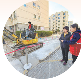
翟董武(右)现场查看更换污水管道施工情况。
