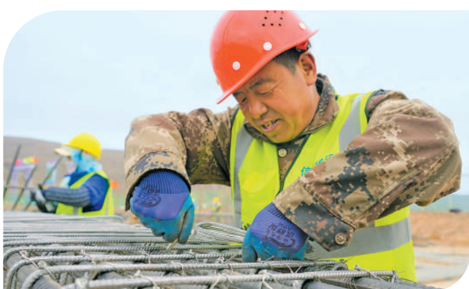
工人在项目建设现场捆绑钢筋。
