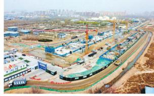
3月24日,银川市西夏区南部片区排水防涝设施雨水 调蓄池建设二期工程建设现场机声隆隆,工人们正在快速 推进工程进度。工程预计5月初达到试运行条件,届时,雨 水调蓄量可达9万立方米,将对缓解西夏区部分路段积水、水污 染问题起到关键作用。本报记者 马楠 实习生 乔新宇 摄
