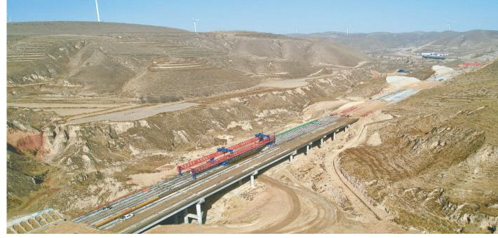
3月25日,空中俯瞰中铁二十局市政公司银昆高速公路宁夏段LJ09-3标段架梁现场,第2045片T梁顺利完成架设,标志着该标段主体结构全部完 成,项目施工进入最后冲刺阶段。银昆高速公路在我区境内全长237公里,其中LJ09-3标段起于固原市原州区寨科乡刘沟村,止于彭阳县交岔乡关 口村,全长12.5公里,标段内分布大桥14座,总计需架设T梁2045片,是银昆高速公路全线T梁架设线路最长、数量最多的标段。本报记者 左鸣远 摄
