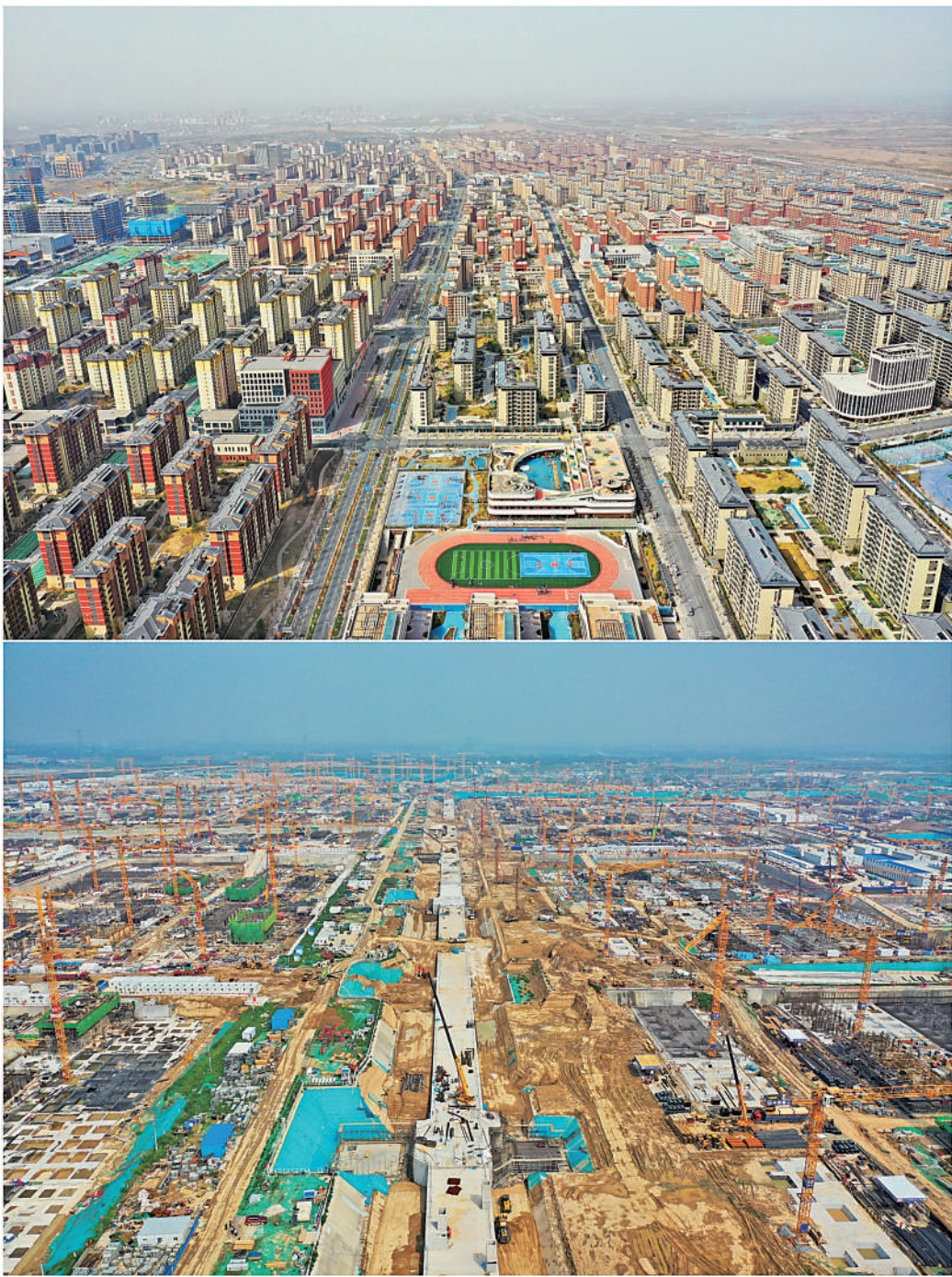
上图为2023年3月24日拍摄的雄安新区容东片区(无人机照片);下图为2020年8月11日拍摄的雄安新区容东片区建设现场(无人机照片)。
