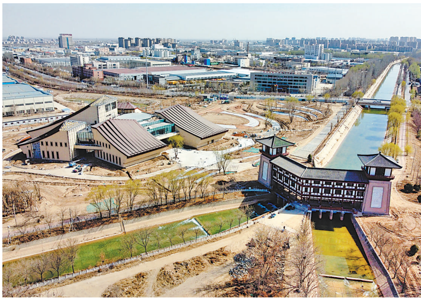
4月3日,初具雏形的宁夏引黄古灌区世界灌溉工程遗产展示中心项目。该项目位于贺兰县丰庆西路以北,总建筑面积9900.94平方米,分室外中心展示区和七个主题展厅,建成后将成为全区青少年水利知识文化研学游基地,并免费向公众开放。项目于2021年8月10日开工建设,目前正实施展馆建筑收尾和内部陈列布展工作,预计今年年底建成。 本报记者 马楠 王洋 摄
