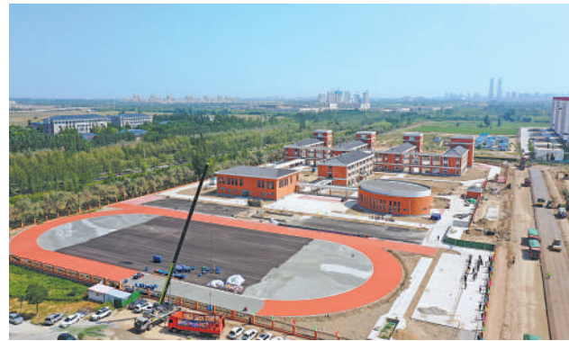
建设中的银川市第二十一小学西夏校区。
