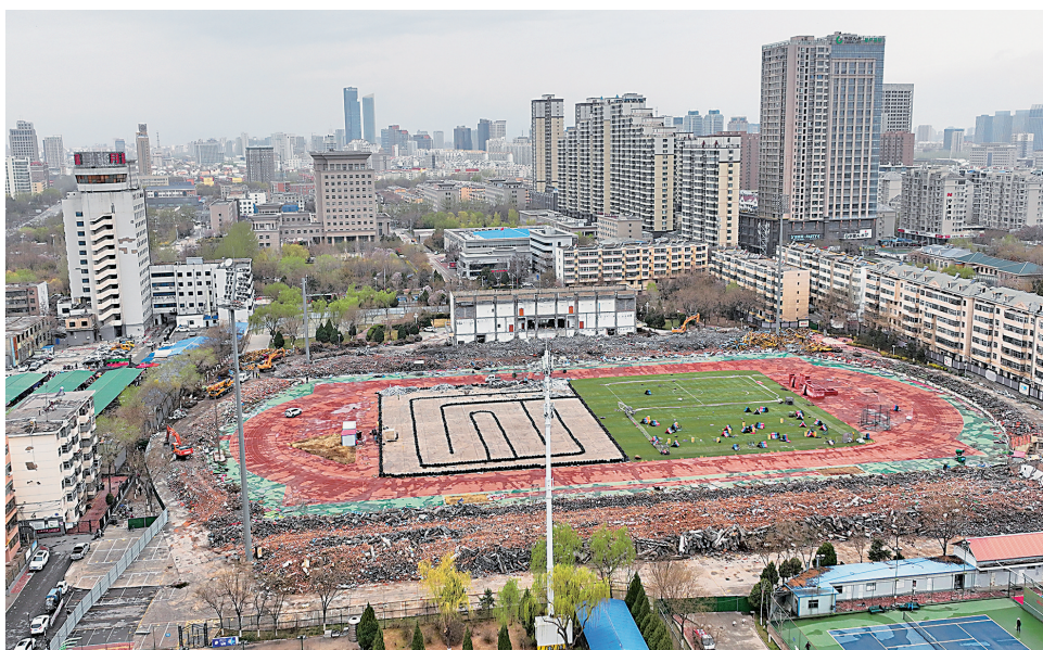
2023年4月5日,正在拆除危险建筑物的宁夏体育场。
