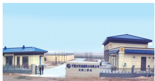
中部干旱带海原西安供水水源工程关桥二泵站。
