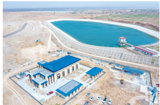
中部干旱带海原西安供水水源工程高崖泵站和水库。
