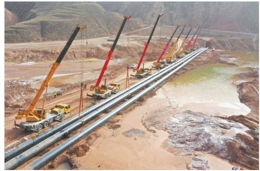
中部干旱带海原西安供水水源工程3号拉管段。
