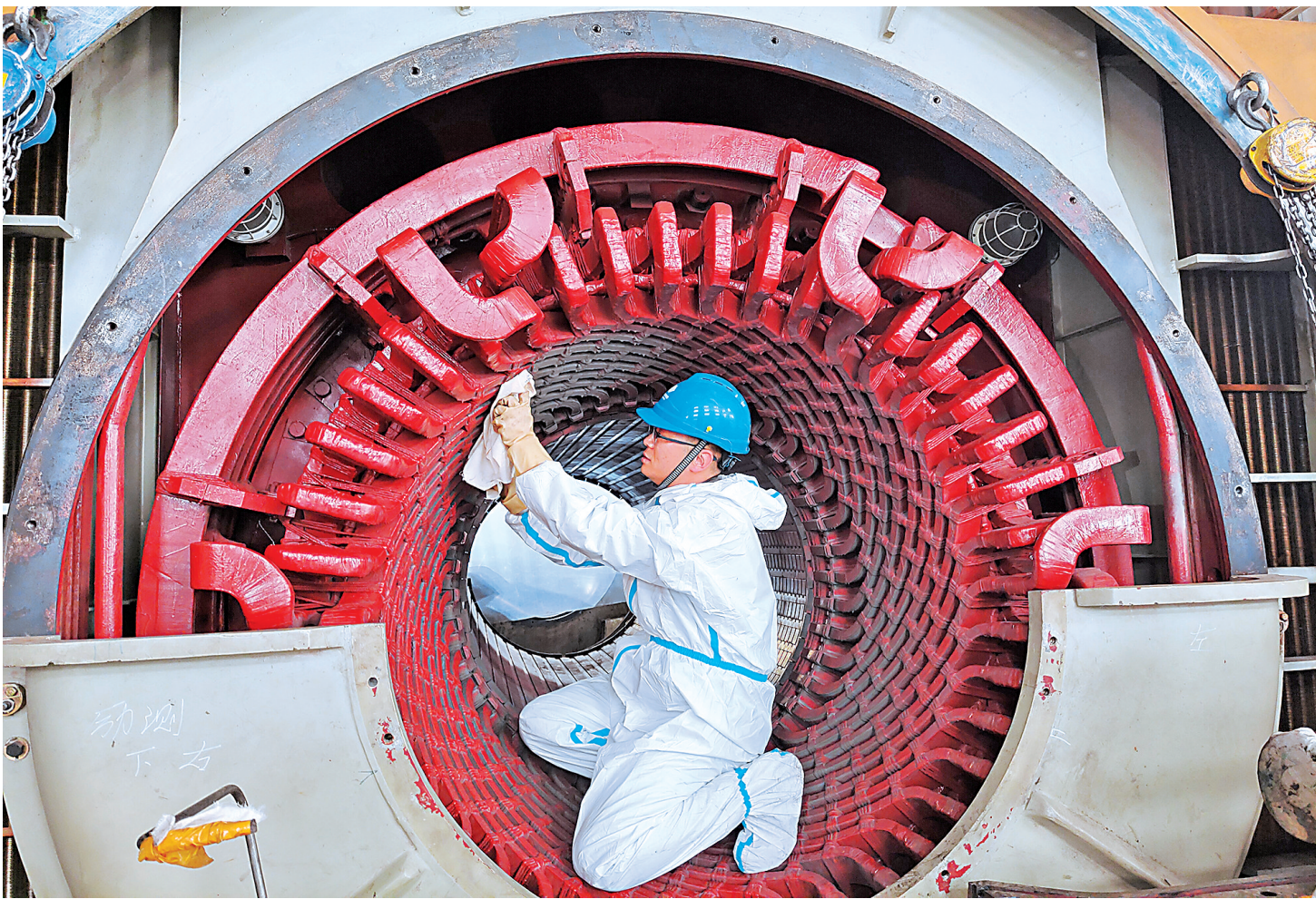
日前,国家能源集团宁夏煤业烯烃一分公司二套生产装置开展为期20天的停车大修工作。本次检修项目涉及1020项,将为装置安全稳定清洁运行奠定基础。 本报通讯员 赵寅 摄
