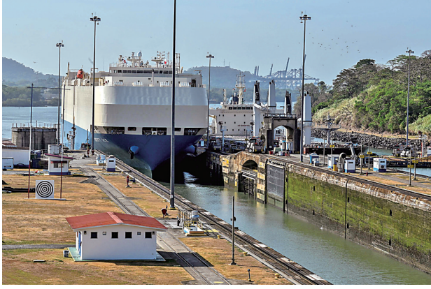
面对干旱,巴拿马运河管理局日前再度调整大型船舶吃水限制,这是该机构今年以来的第五次调整。由于降水不足,为运河供水的加通湖和阿拉胡埃拉湖水位严重下降。其中,阿拉胡埃拉湖水位3月21日至4月21日下降约7米,降幅超过10%。 新华社/法新
