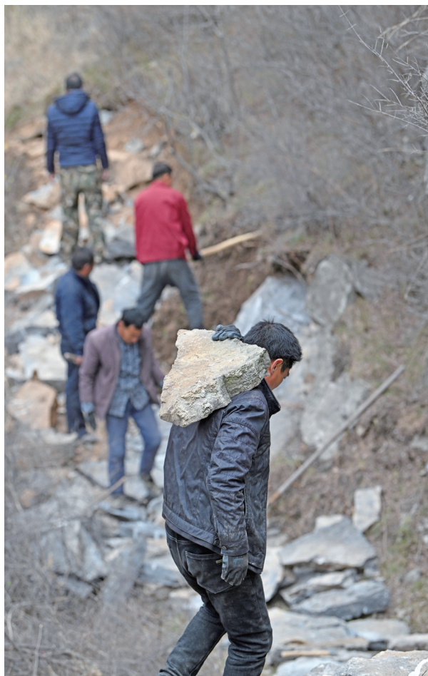
在山西省壶关县大峡谷镇青龙峡村,村民在修路现场搬运石头(2023年3月23日报)。
