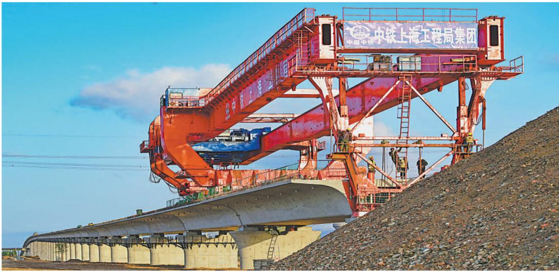
5月5日拍摄的包银高铁跨万甘铁路特大桥箱梁架设施现场。当日,由中铁上海工程局承建的包(头)银(川)高铁跨万甘铁路特大桥箱梁架架任务完成,标志着包银高铁内蒙古首段首座跨铁路特大桥主体工程结束。跨万甘铁路特大桥全长2526.8米,设计共78孔预制箱梁,箱梁架架任务的完成为后续铺轨奠定了坚实基础。包银高铁是我国“八纵八横”高速铁路网京兰通道的重要组成部分,设计时速250公里。 新华社发
