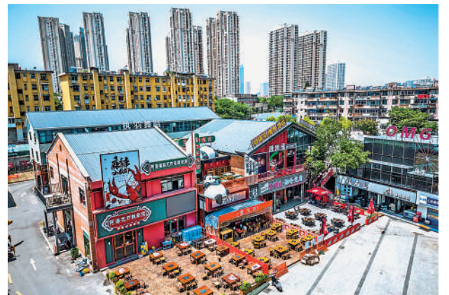
5月9日拍摄的由老仓库改造的瑶海区徽商2号门文创街区(无人机照片)。安徽省合肥市瑶海区是老工业城区。近年来,该区积极推进老城区城市更新,有效利用辖区老工厂、老厂房、老仓库等资源,创意点亮工业历史,打造了一批集创意办公、文展展示、工业记忆、休闲娱乐及消费等功能为一体的文创艺术街区。新华社发
