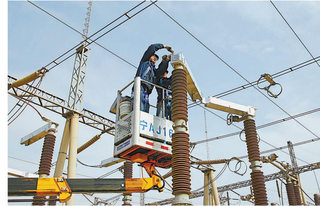
5月16日,电力工人在掌政220千伏变电站开展检修作业。当日,在银川枢纽变电站掌政220千伏变电站,国网银川供电公司员工对运行超过10年的220千伏隔离开关进行大修作业,更换新式导电臂并进行调试,消除隐患缺陷,保障夏季可靠供电。本报通讯员 袁宏彦 摄
