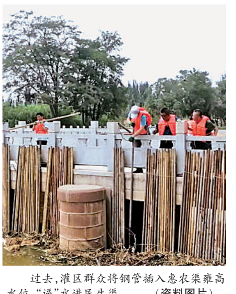
过去,灌区群众将钢管插入惠农渠雍高水位,“逼”水进民生渠。(资料图片) (资料图片)
