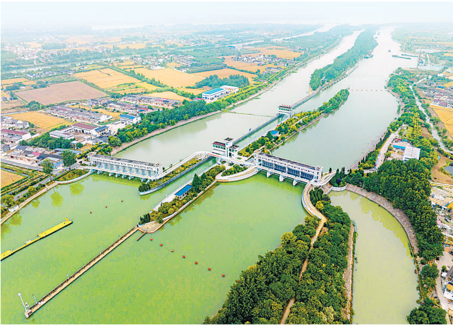
6月1日拍摄的位于江苏省扬州市江都区的南水北调东线一期工程运盐闸、邵仙套闸、邵仙闸洞。据悉,南水北调东线2022年至2023年度苏鲁省界调水于5月29日12时结束,共向山东省调水8.5亿立方米;南水北调东线北延应急供水工程5月31日20时完成2022年至2023年度调水任务,共向黄河以北调水2.77亿立方米。
