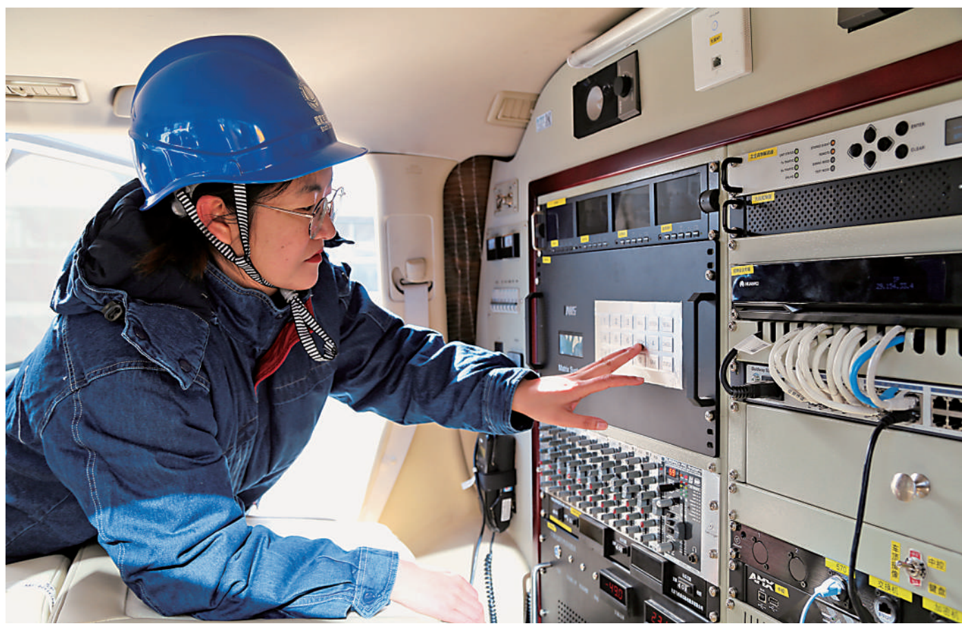
6月4日,技术人员通过中通卫星通信车将现场画面实时回传至指挥部。国网宁夏信通公司联合国网银川供电公司开展“高考保电反事故应急演练”,提升运维监控应急处置联动能力以及突发事件现场应急通信保障能力,确保高考期间电网安全稳定运行。本报记者 左鸣远 摄
