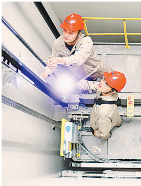
↑6月8日,银川建发悠阅城在建项目现场,检验人员对新装电梯进行检验。
