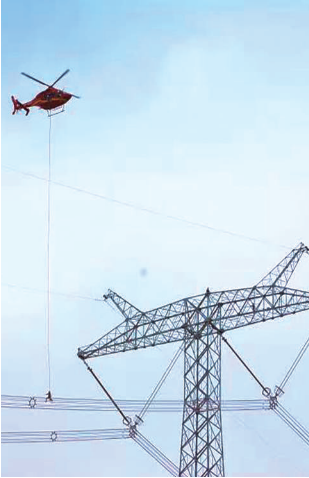
国网宁夏电力有限公司在世界上首次利用直升机吊索法对世界最高电压等级的±1100千伏输电线路开展带电作业。
