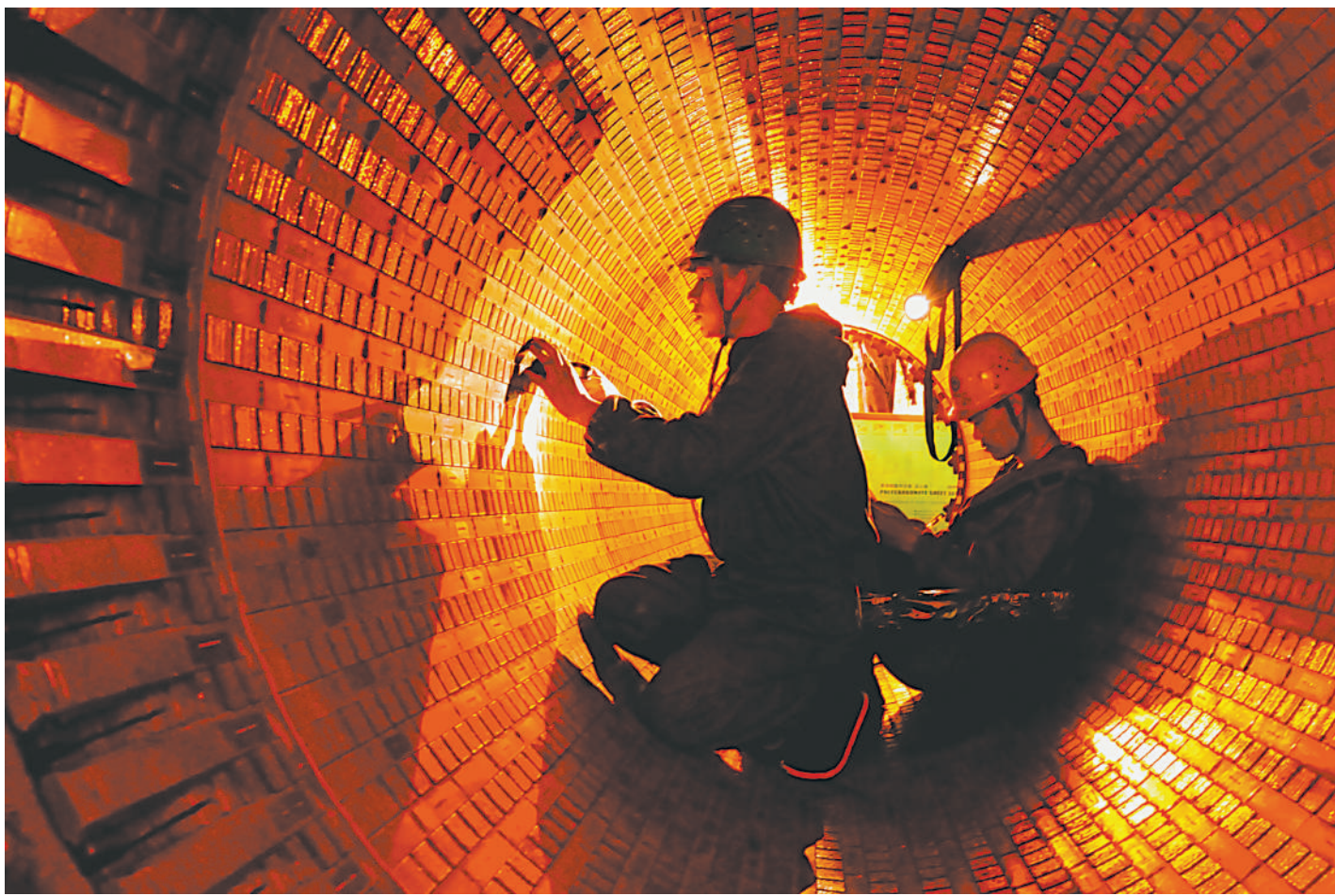
6月8日,国能宁夏灵武发电有限公司职工在发动机定子膛内进行检查,确保完成机组检修任务,为迎峰度夏提供能源保障。 本报通讯员 张宗新 摄
