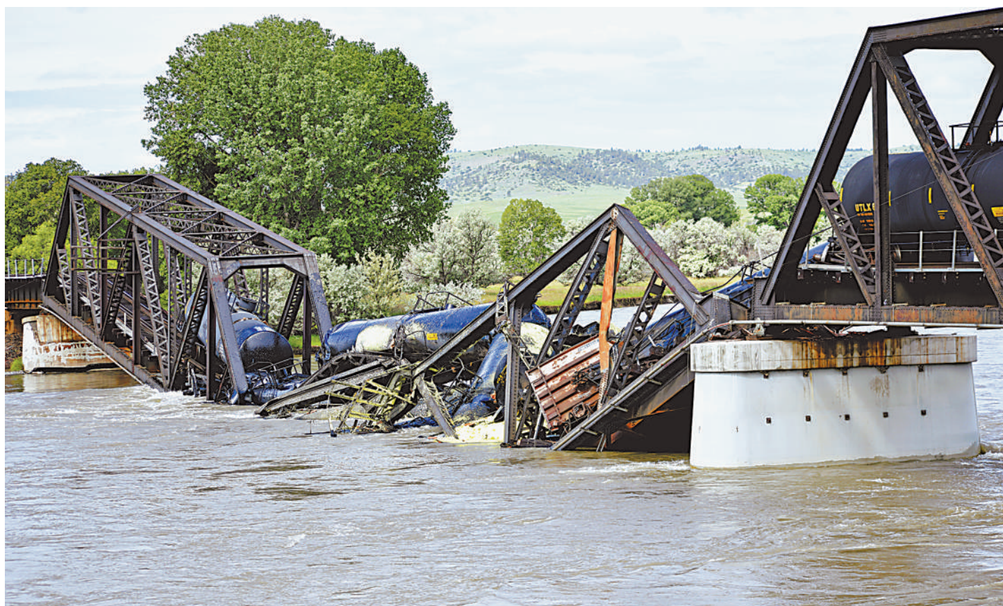
这是6月24日在美国蒙大拿州哥伦布附近拍摄的倒塌的桥梁和坠入黄石河中的火车。据外媒报道,一列货运火车当日在经过黄石河上的桥梁时遭遇桥梁倒塌并坠入河中。
