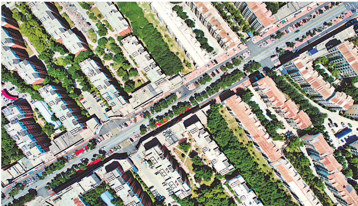
近日,俯瞰银川市兴庆区熙春巷(北京路—上海路),崭新的慢行绿道贯穿在林立的居民楼间。作为银川市交通疏堵“6+N”工程之一的熙春巷慢行绿道工程,改造道路1003米,惠及周边8个大型居民小区,经过近3个月的施工,目前全部完工恢复通行。 本报记者 马楠 王洋 摄
