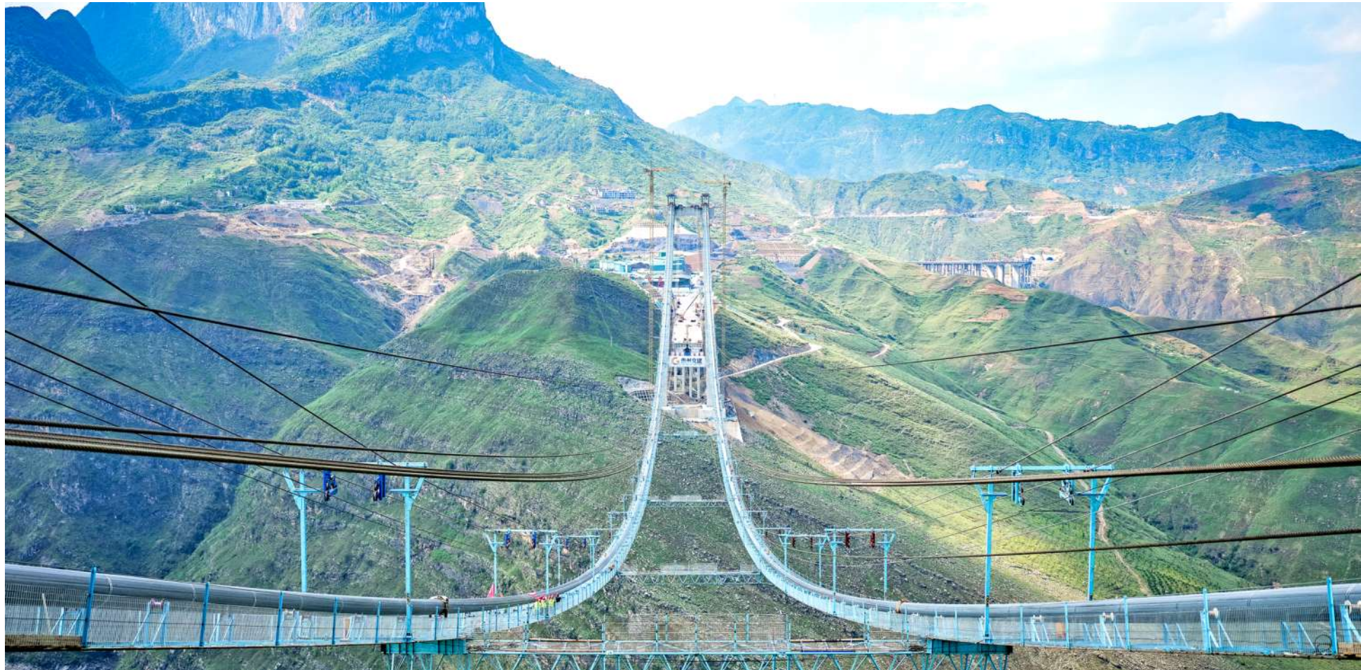
纳晴高速群柯江大桥主缆牵引顺利完成(6月25日摄)。6月25日,纳晴高速群柯江大桥主缆牵引顺利完成,大桥上部结构施工陆续转入紧缆、吊索安装和主桥钢桁梁吊装阶段,为纳(雍)晴(隆)高速全线通车进一步创造有利条件。群柯江大桥位于贵州省晴隆县和普安县交界处,大桥全长1849米,主跨1080米。新华社发
