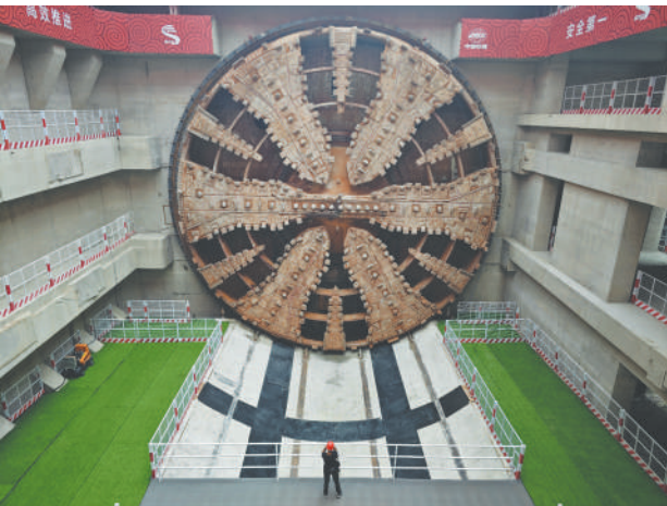
6月28日,国产最大直径盾构机——“京华号”盾构机出洞,由中铁十四局承建的北京东六环改造工程西线隧道顺利贯通。这是目前我国最长盾构高速公路隧道,标志着这一国家级创新工程取得重大进展。 新华社发
