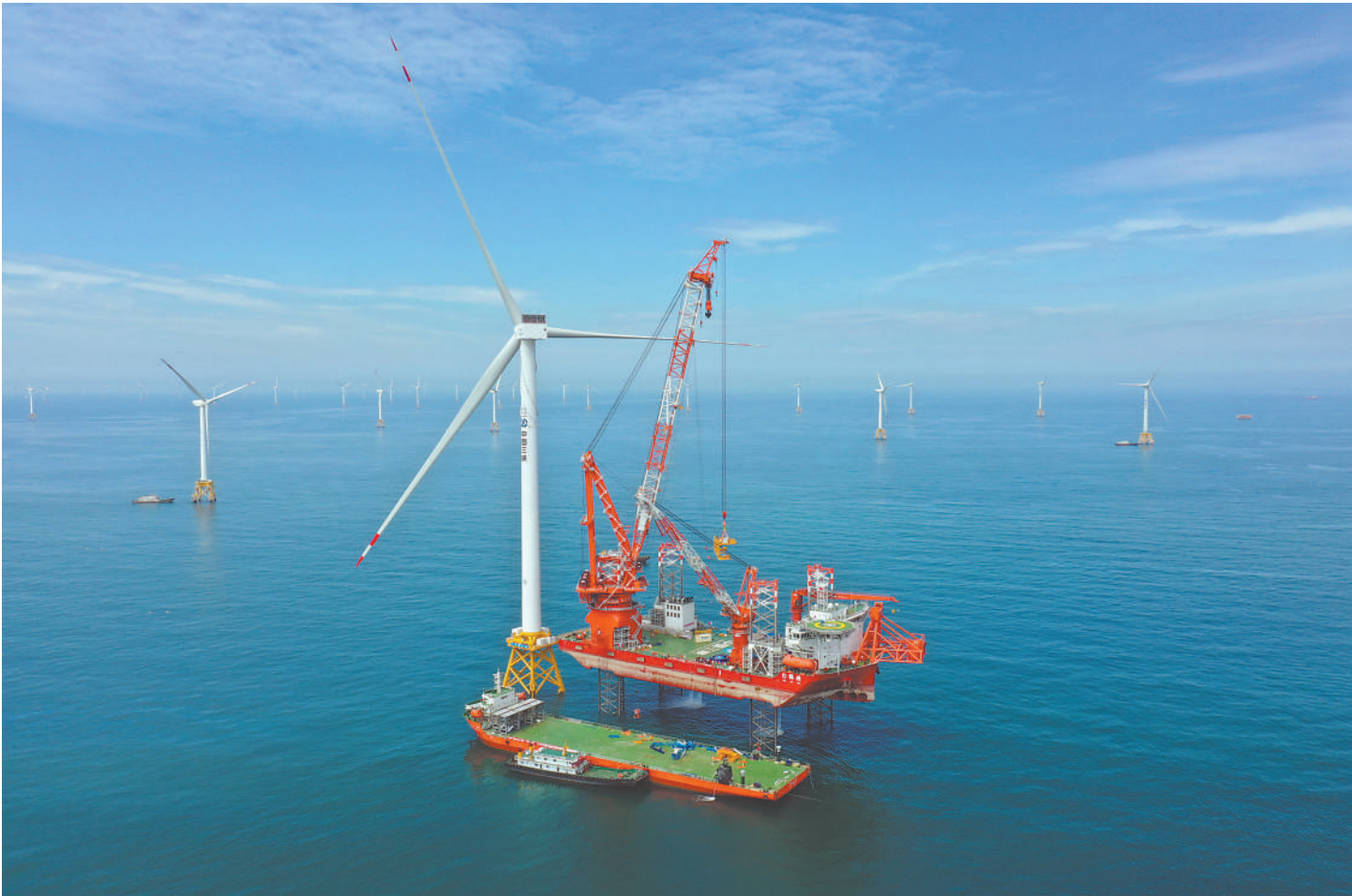
6月28日拍摄的全球首台16兆瓦海上风电机组吊装现场(无人机照片)。记者从中国三峡集团获悉,全球首台16兆瓦海上风电机组6月28日在福建北部海域顺利完成吊装。这标志着我国海上风电高端装备制造能力、深远海海上风电施工等全产业链实现整体提升,达到国际领先水平。 新华社发
