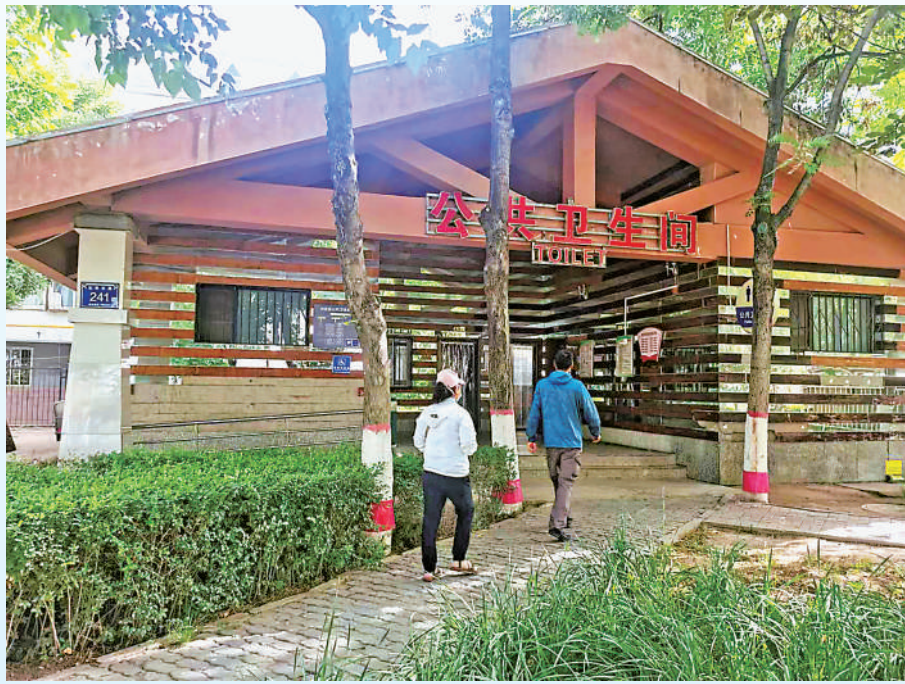
银川市北京路与进宁街交叉路口附近的公共卫生间为市民提供方便。
