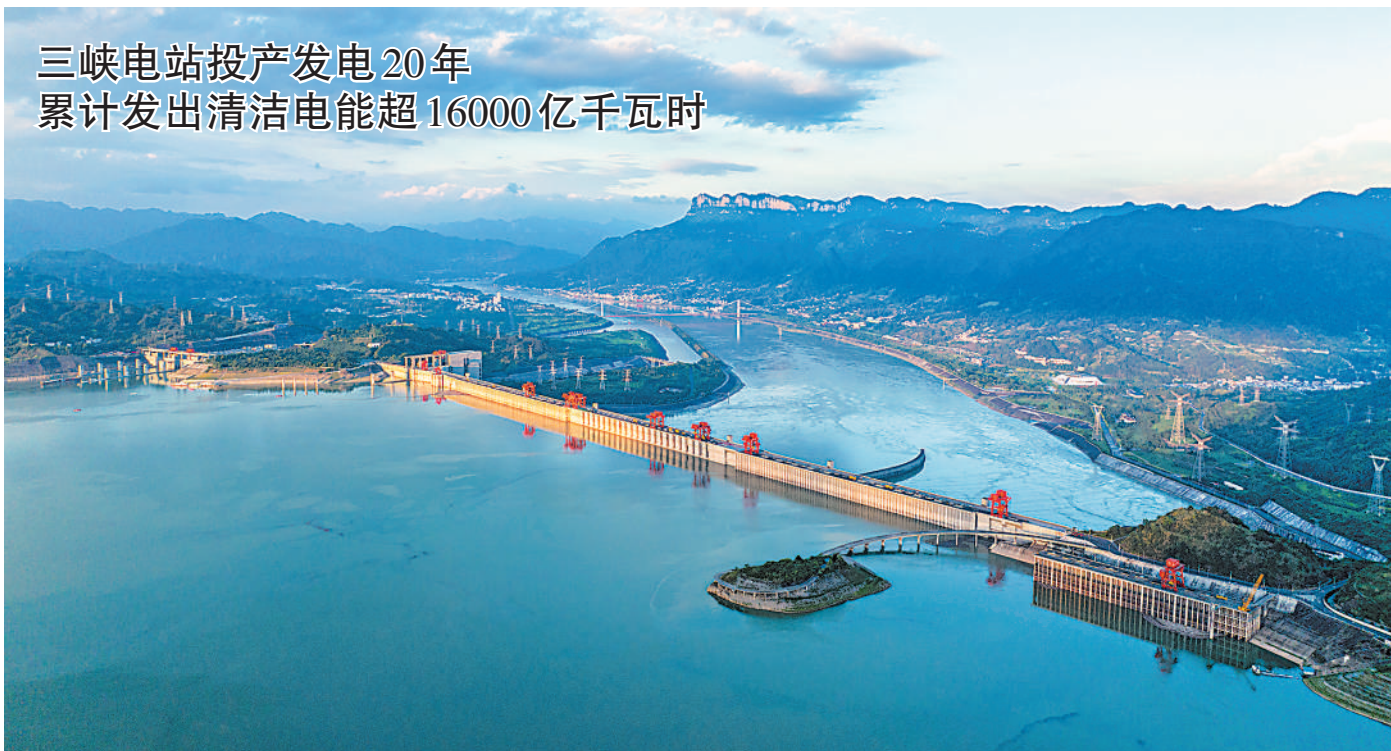
这是7月9日在湖北省宜昌市拍摄的夕阳映照下的三峡水利枢纽工程(无人机照片)。2023年7月10日,三峡电站首台机组投产发电整20年,20年来,三峡电站已累计发出16000多亿千瓦时清洁电能。三峡电站共安装34台水轮发电机组,总装机容量2250万千瓦,年设计发电量882亿千瓦时,是我国“西电东送”和“南北互供”的骨干电源点,电能昼夜不息被送往华东、华中、广东等地。
