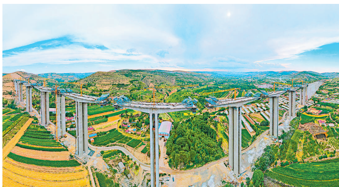
7月24日,由中铁二十局负责施工的银昆高速公路宁夏段LJ13-1标段友联红河特大桥建设正在加速推进。目前,特大桥下部结构已全部完成,悬挑梁施工完成70%,预计今年年底该标段主体工程完工。本报记者 左鸣远 赵磊 摄
