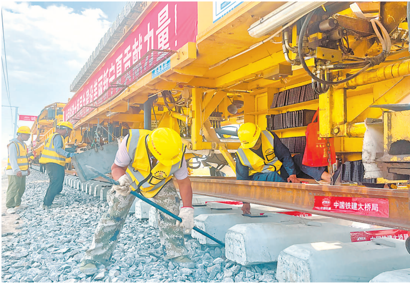
铺轨作业采用先进的“单枕法”铺轨,实现“一根轨”设计,轨道铺设精度高,安全性强。
