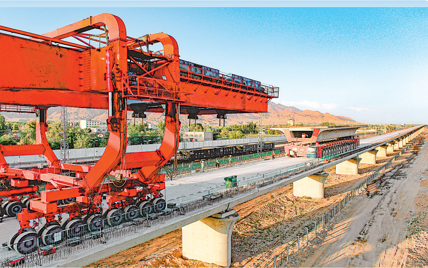
包银高铁巴彦淖尔段首座跨铁路专用线特大桥梁箱梁架设完成
