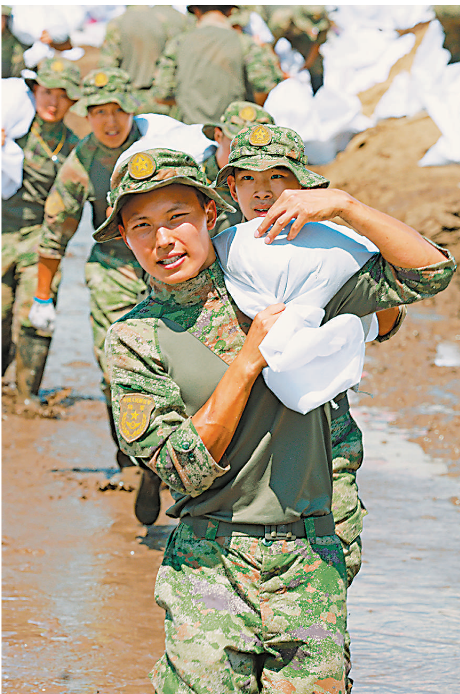
↑北部战区陆军第78集团军某旅组织官兵在黑龙江哈尔滨市双城区万隆乡增产村封堵管涌。 →搬运沙袋加固堤坝。
